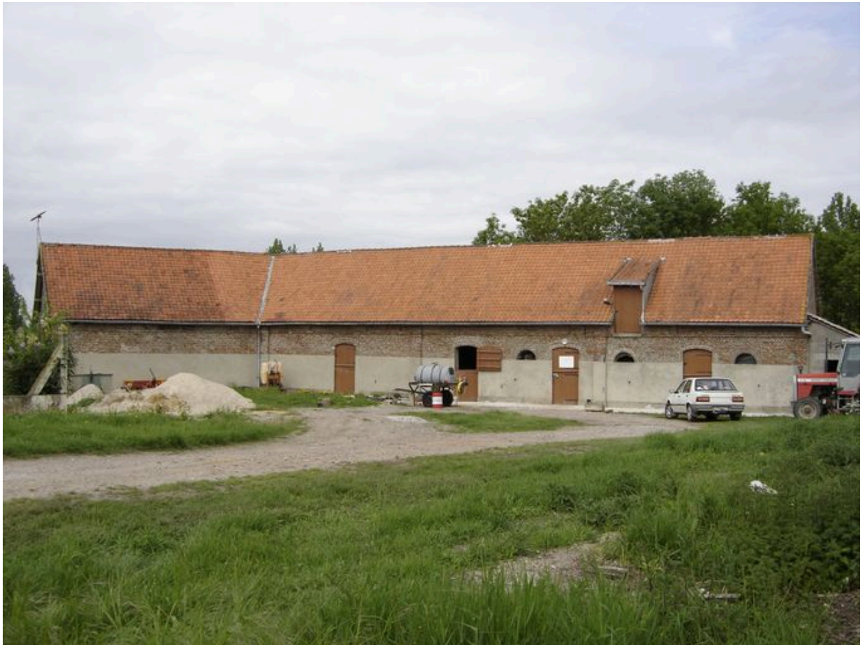
Vue générale des bâtiments agricoles.
