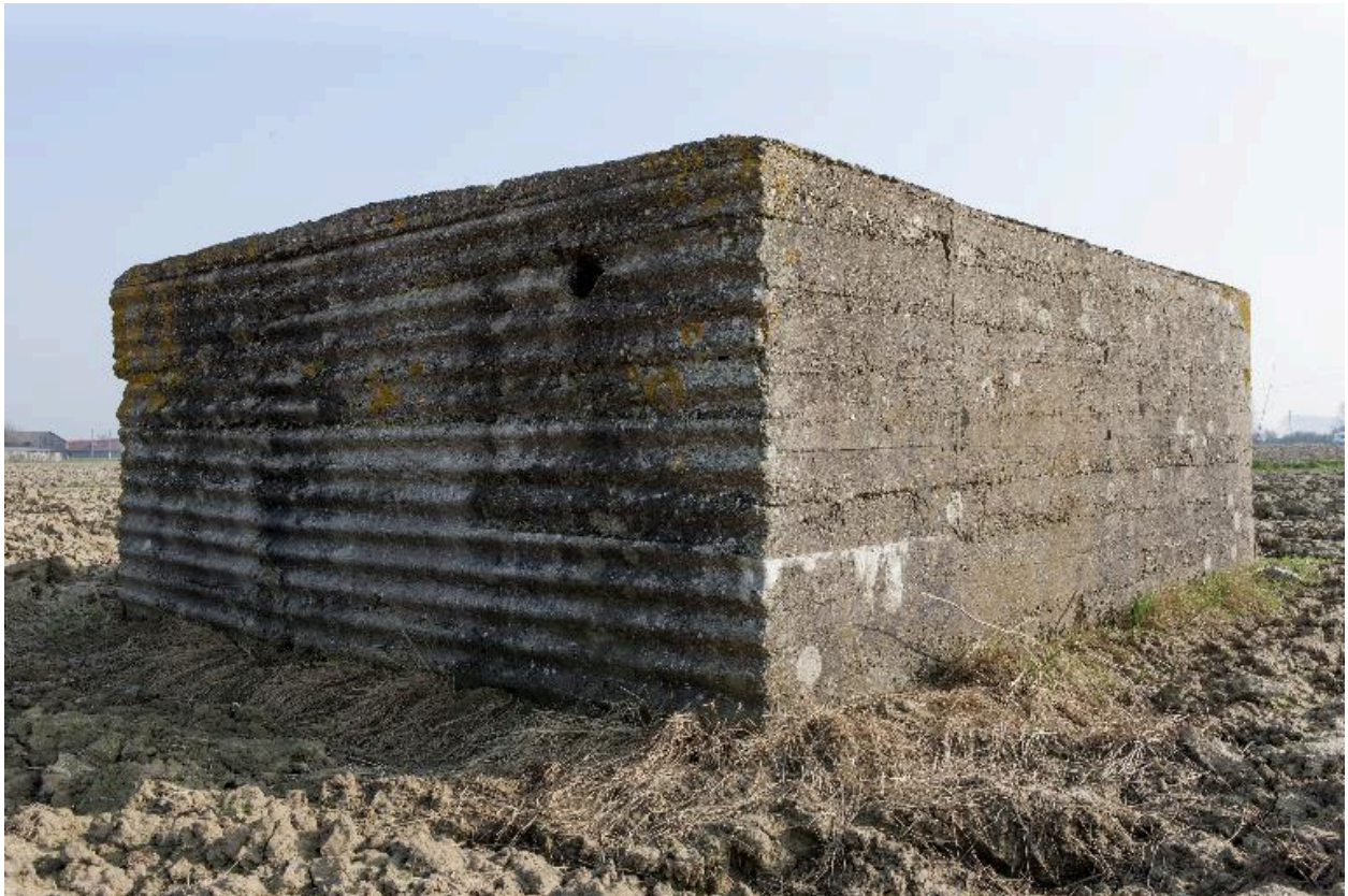
Vue de trois-quarts vers le sud-est
