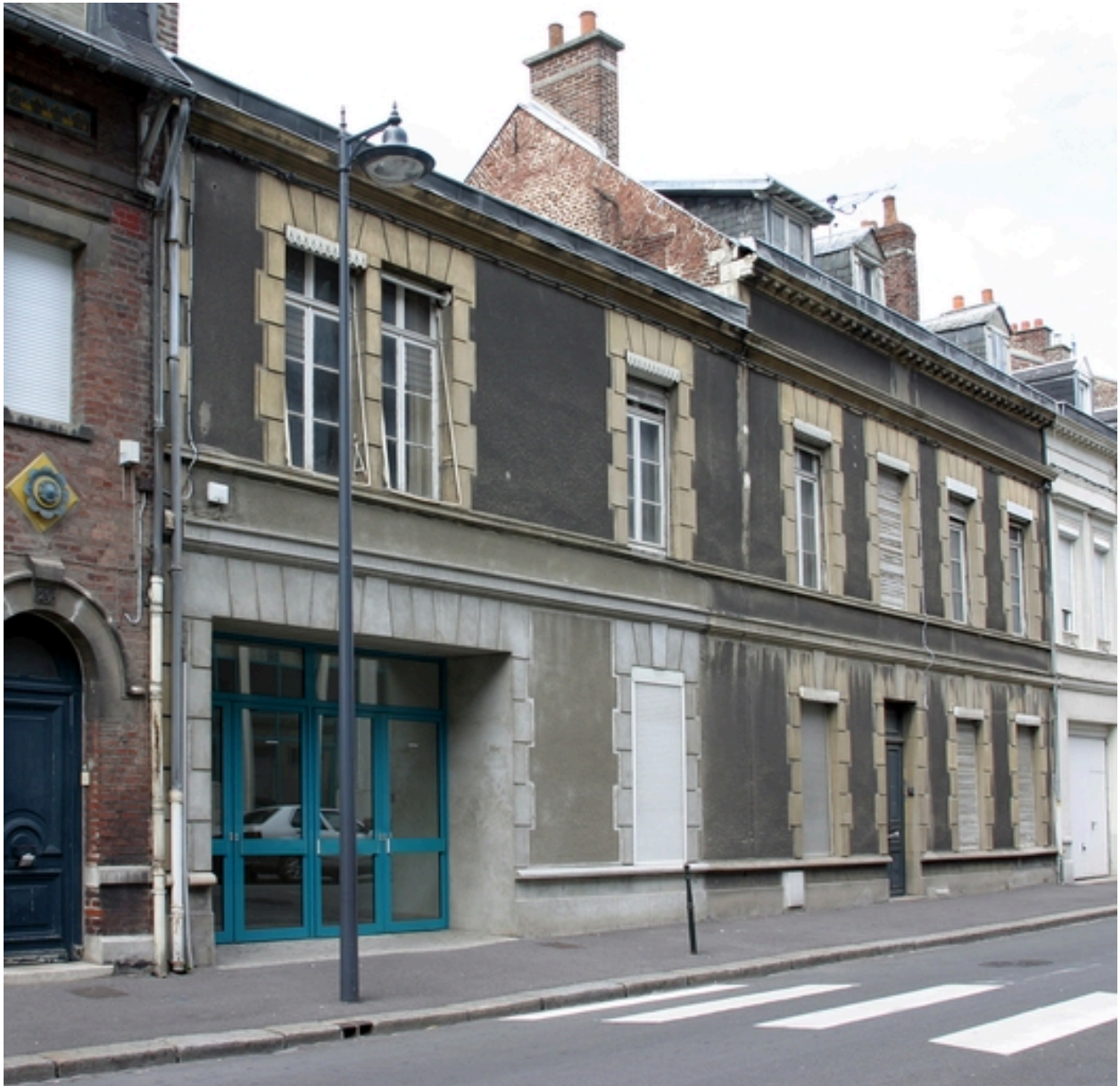
Vue des bureaux, rue Antoine-Lecuyer.
