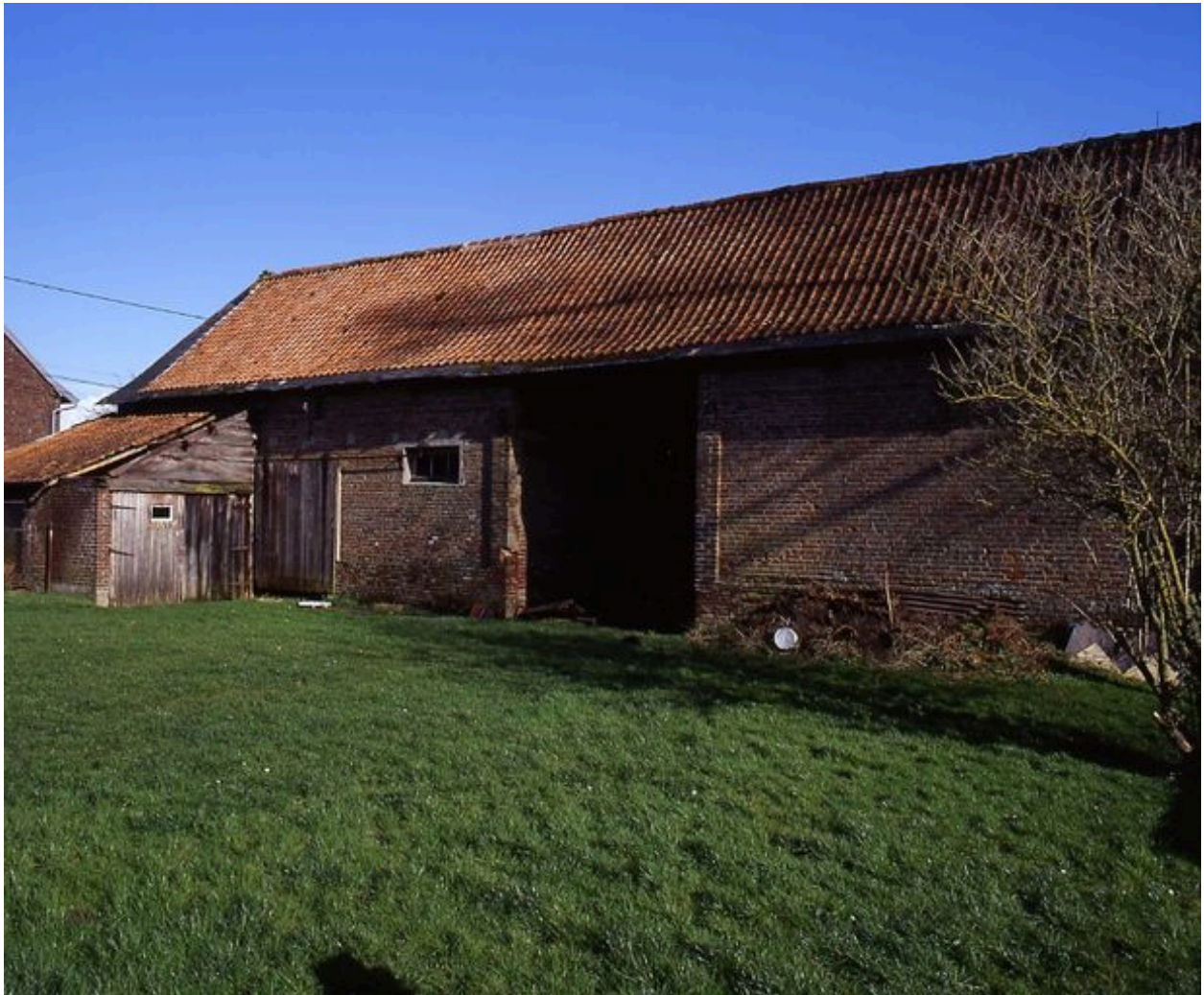
Vue de la grange.
