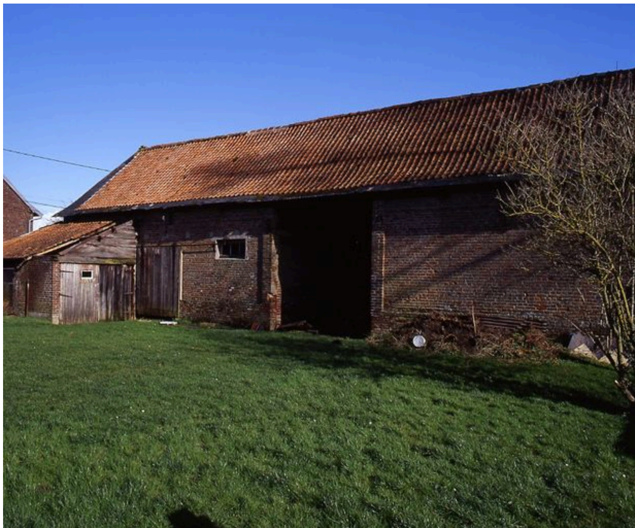
Vue de la grange.
