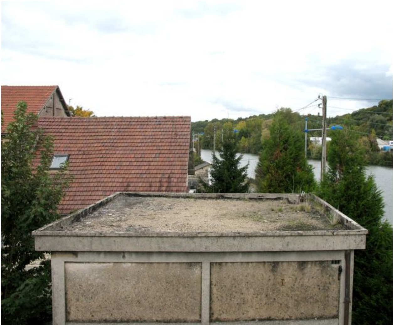
Toit terrasse du transformateur.
