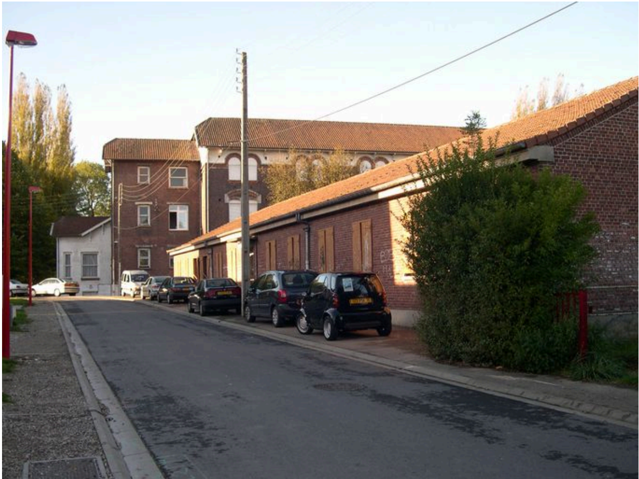
Ecole de la SNCF, vue depuis le nord-est.
