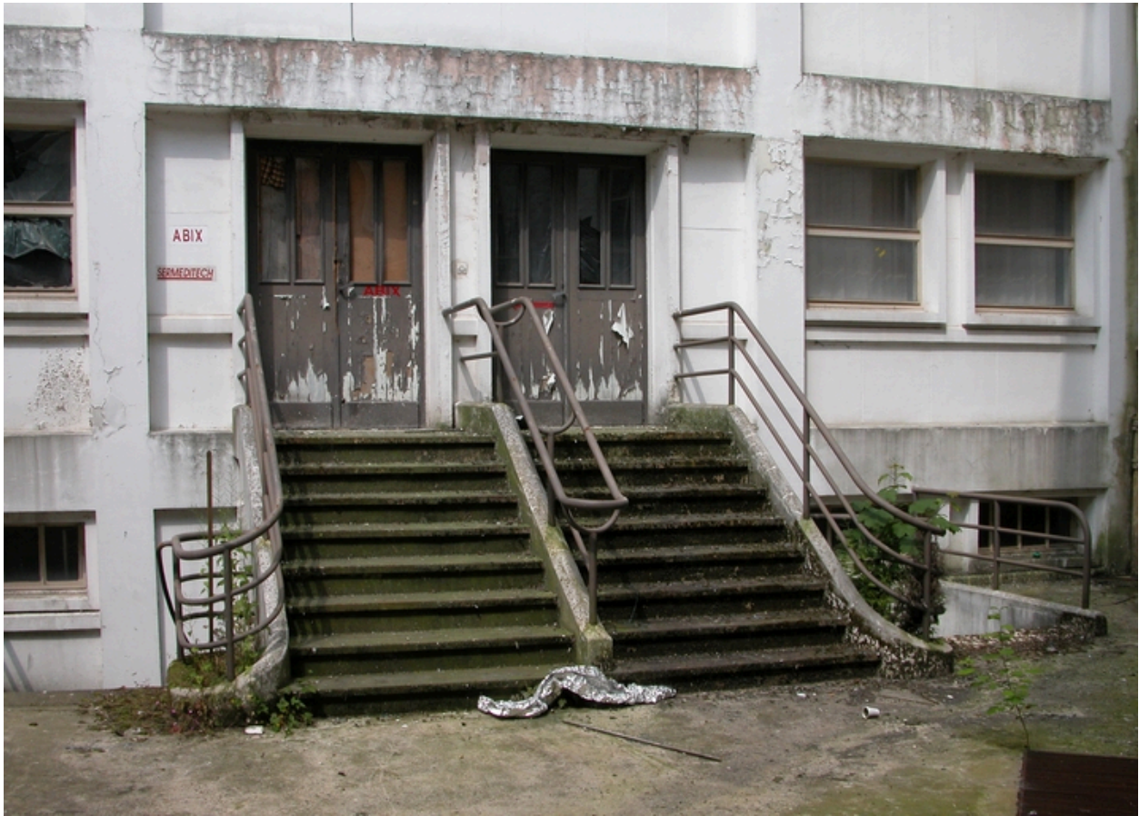
Escaliers dans la cour de l'usine.
