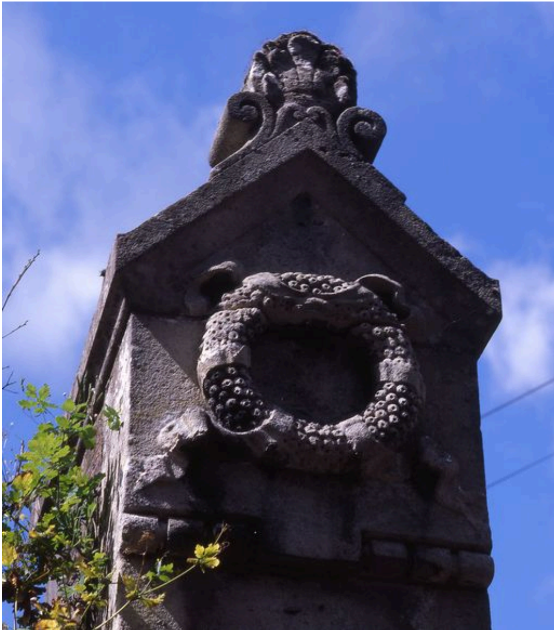
Le portail d'entrée, rue d'Elbeuf, vue de détail du décor du pilier.
