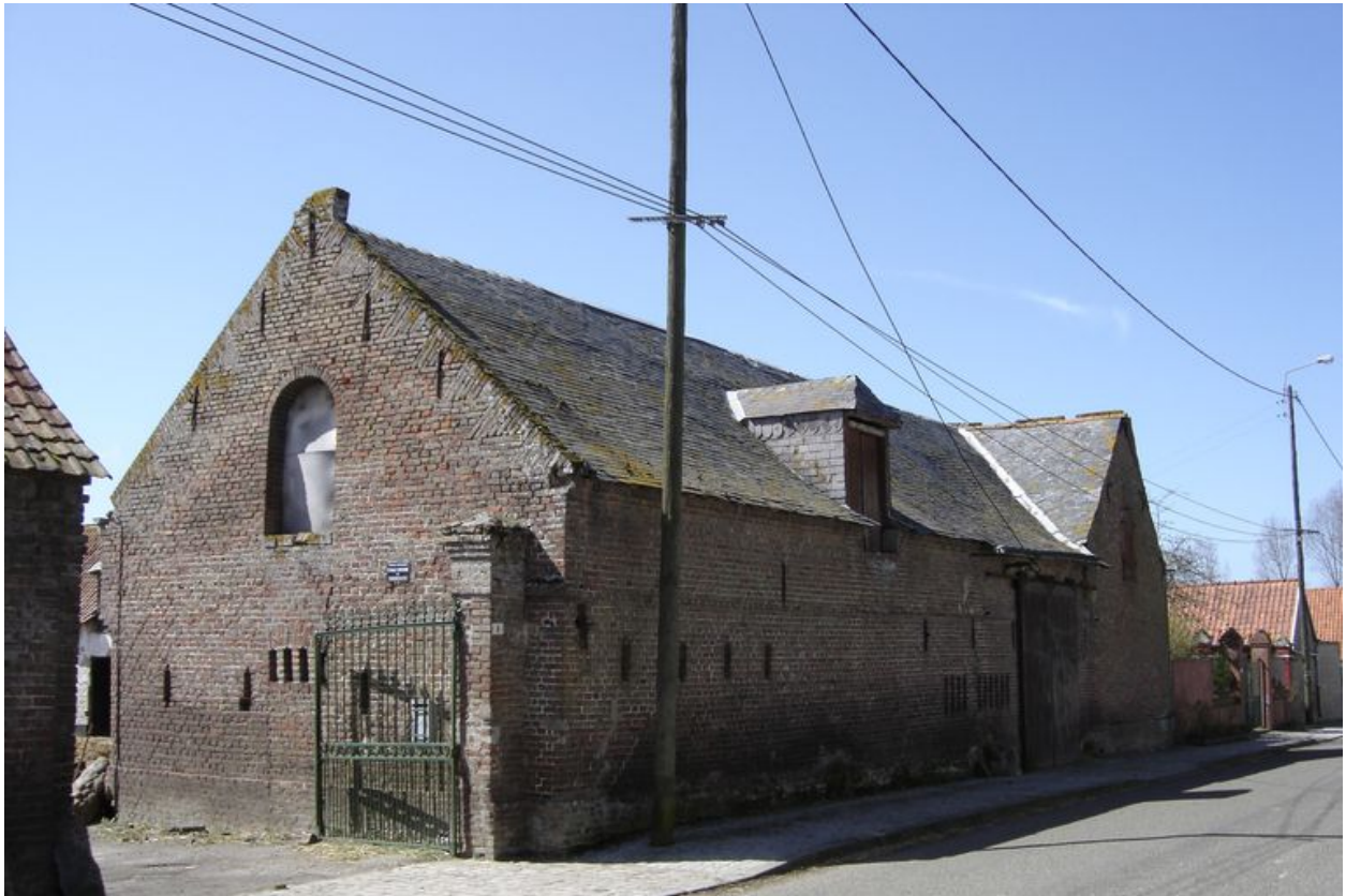
Vue de la bergerie depuis la rue.
