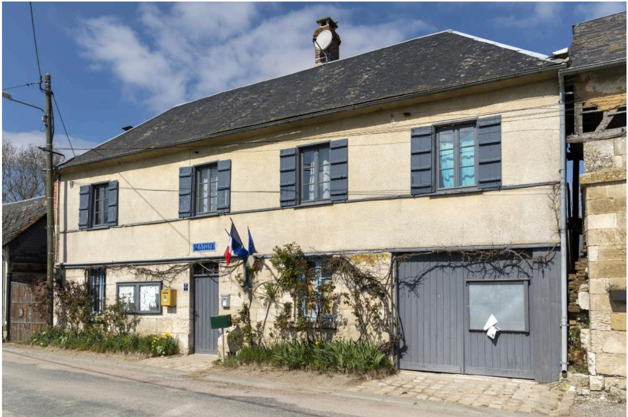
Vue de la façade sur rue de la mairie-école (ancienne boulangerie), n°1bis rue Principale.
