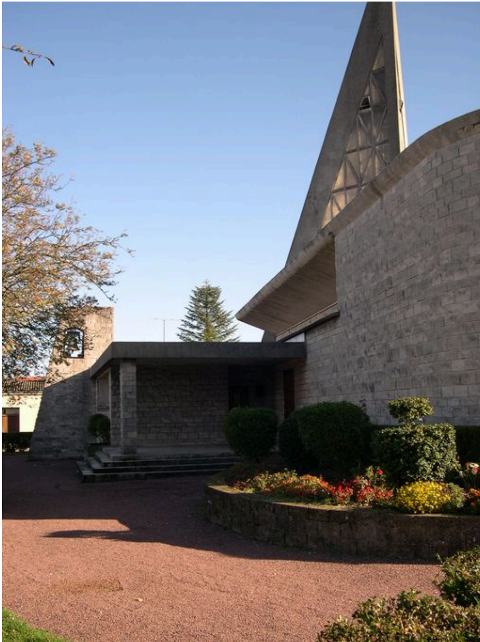
Vue depuis le sud-ouest.
