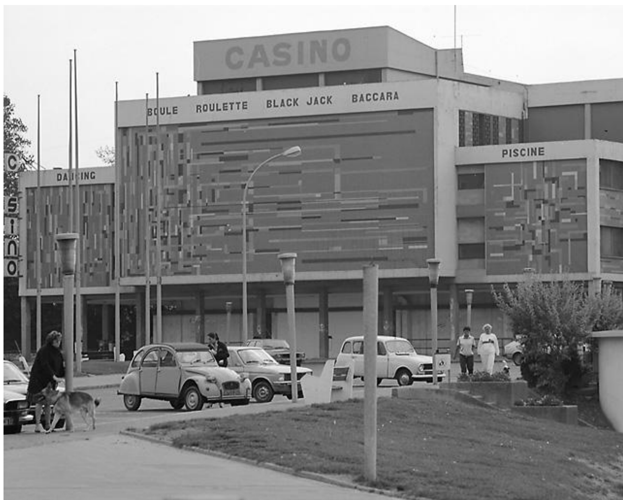
Casino municipal, façade d'entrée nord-est.
