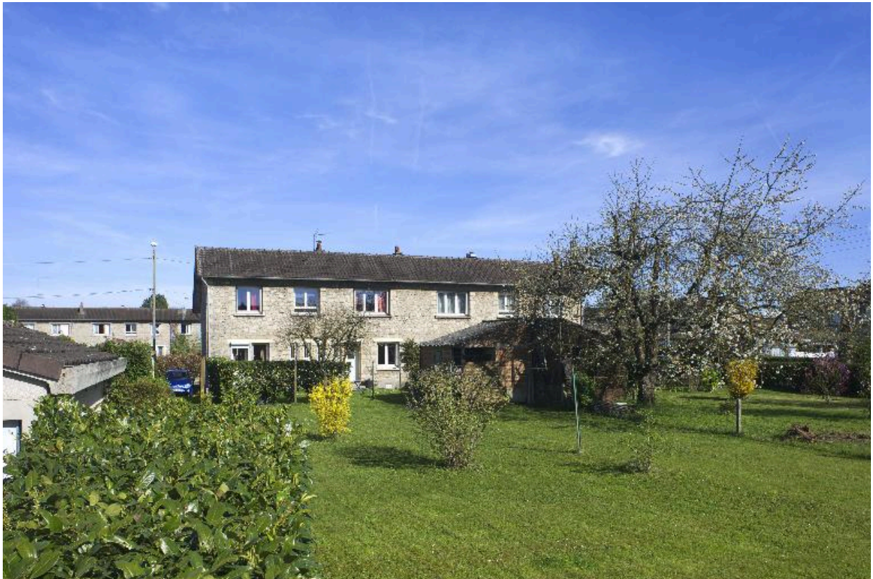
Maison à quatre unités d'habitation (rue de Verdun). Vue de situation avec les jardins au premier plan.
