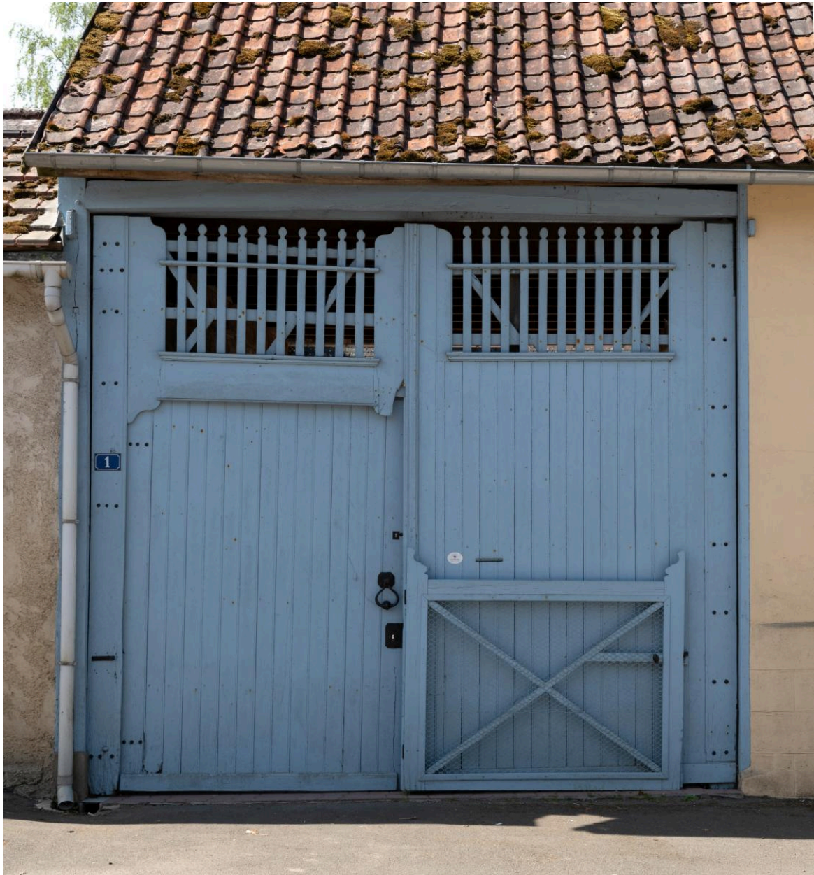
Entrée charretière avec "grand'portes", n°1 rue Notre-Dame, vue depuis le nord.
