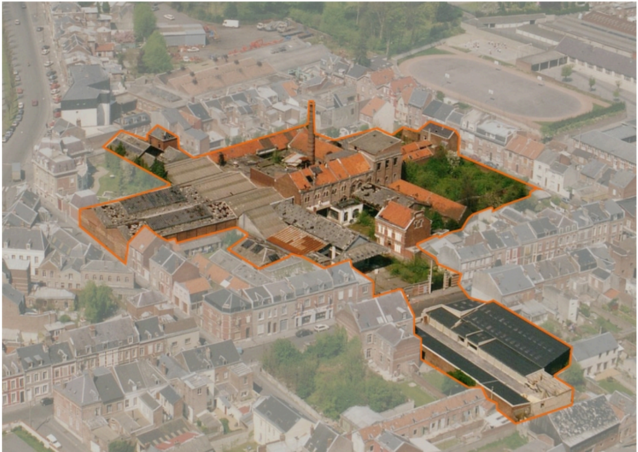
Vue aérienne de la brasserie vers 1989 (BM Saint-Quentin).
