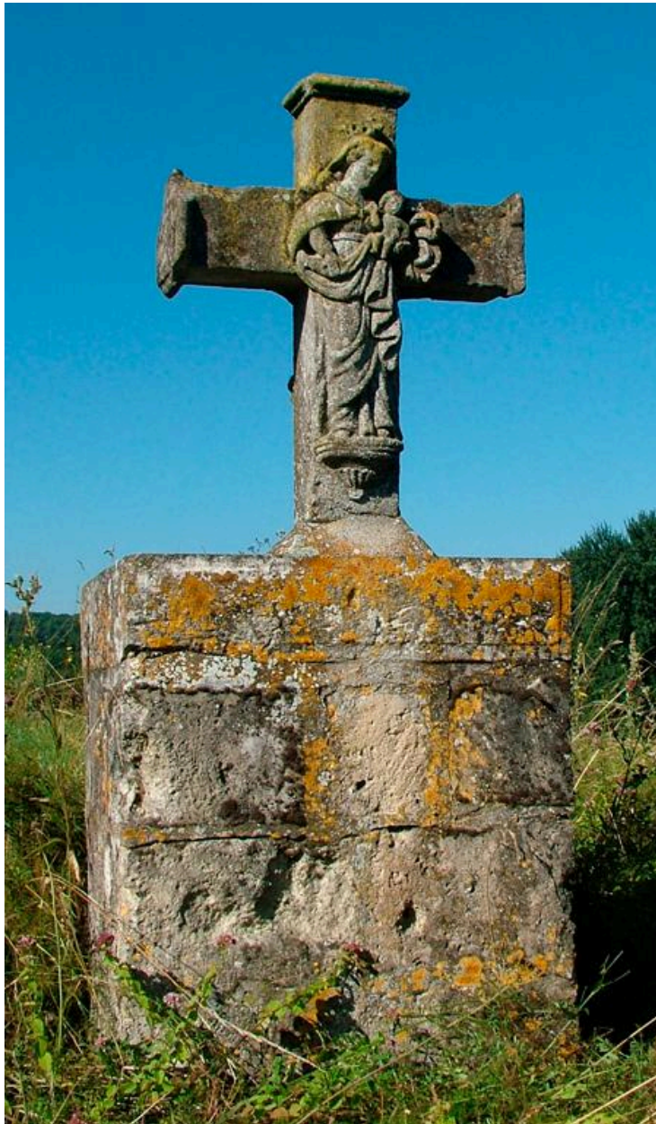
Vue générale de la face sud.
