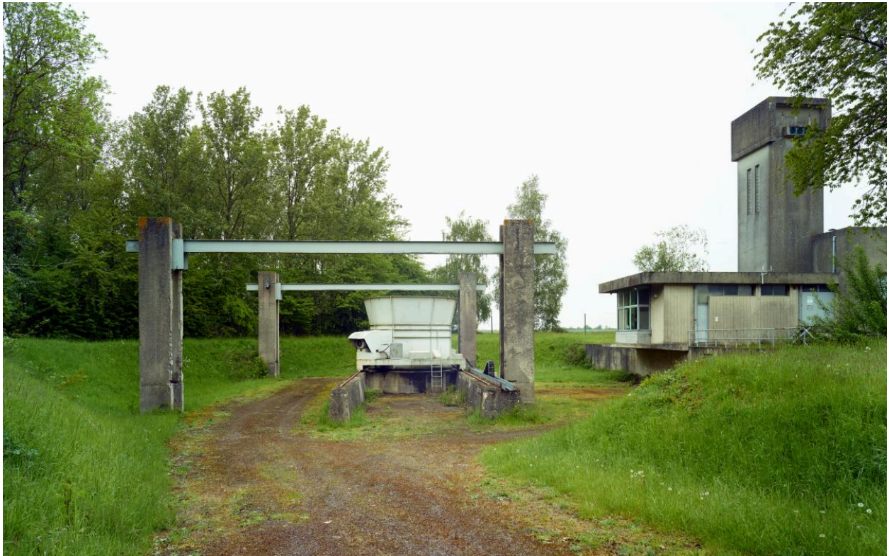
Poste de commande et turbines de ventilation. Vue depuis le sud-ouest.
