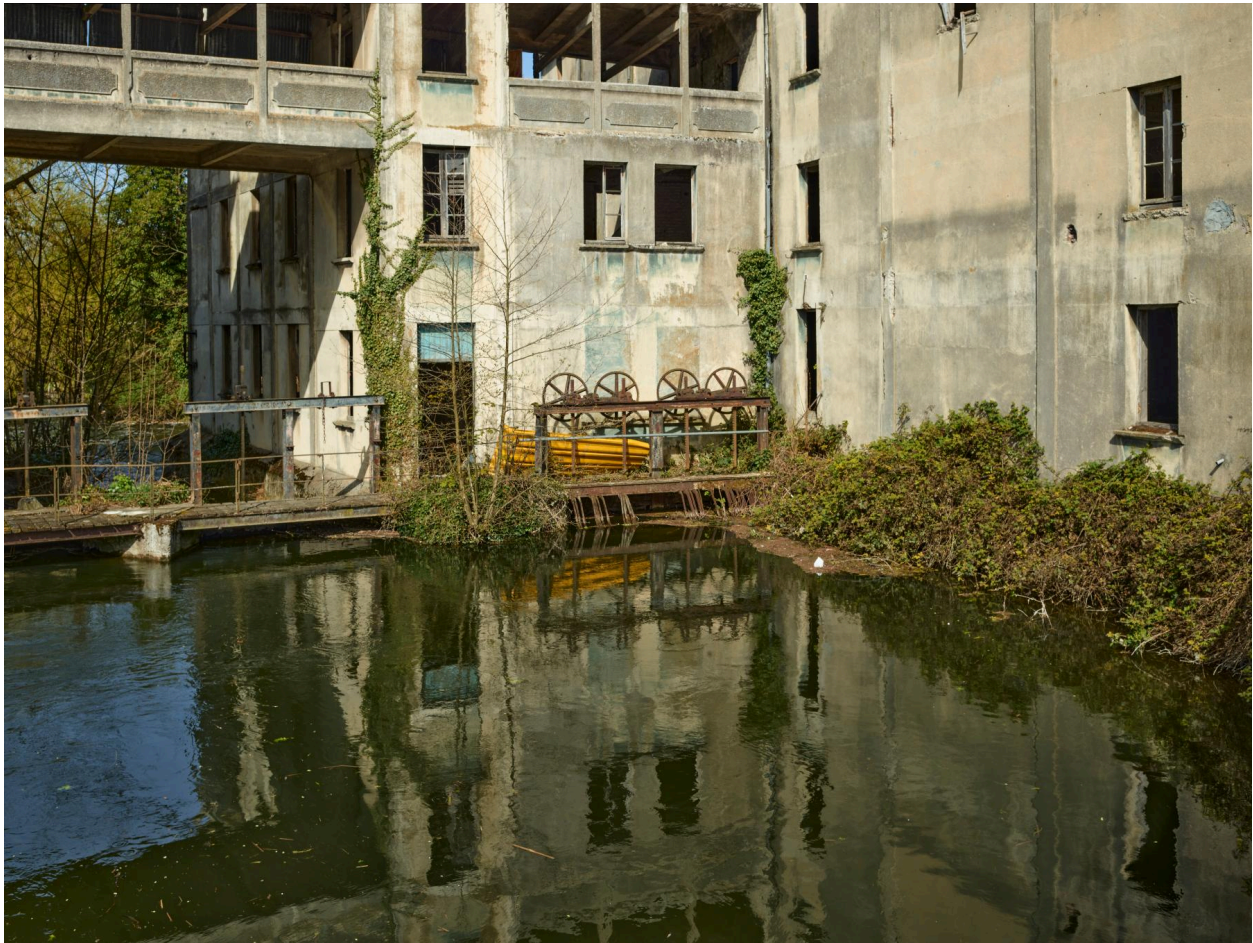
Vannage de la petite roue hydraulique.
