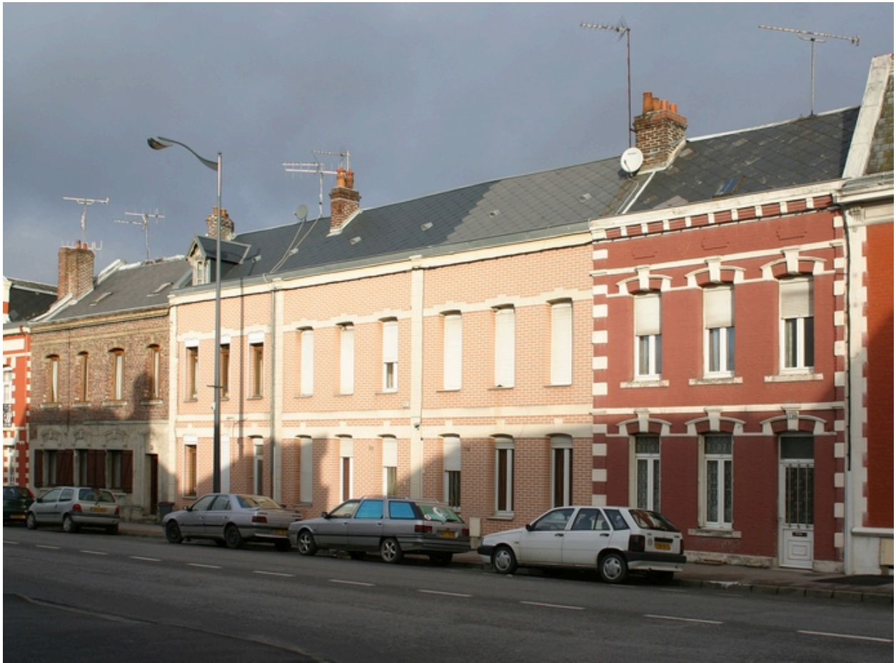
Façade antérieure des logements, rue de Guise.
