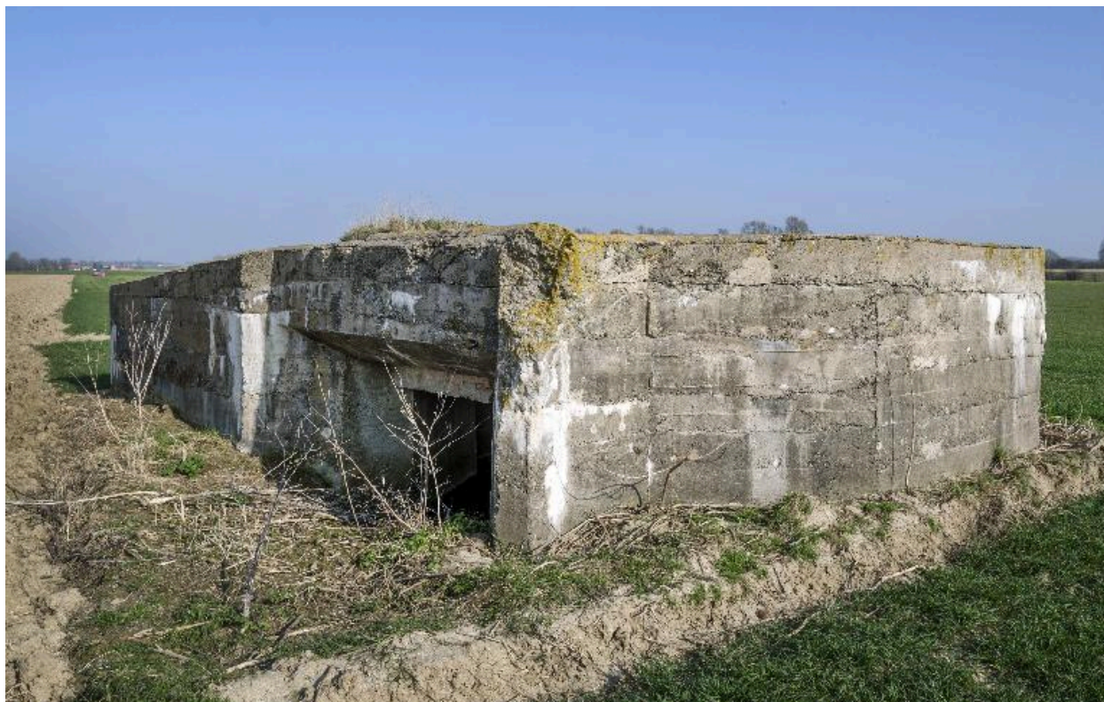
Sortie de la chambre de tir, vers le nord-est
