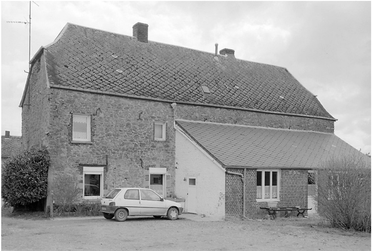
Vue de l'élévation postérieure du logis.
