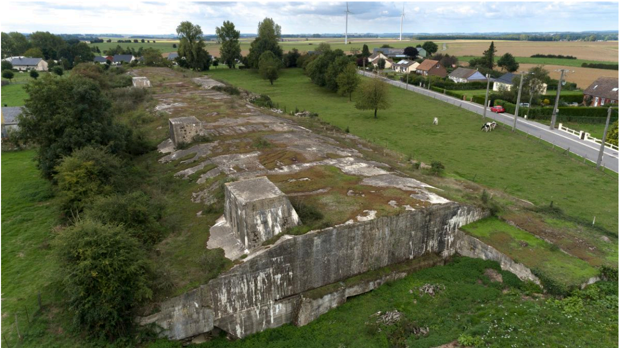
Vue aérienne oblique vers le nord.
