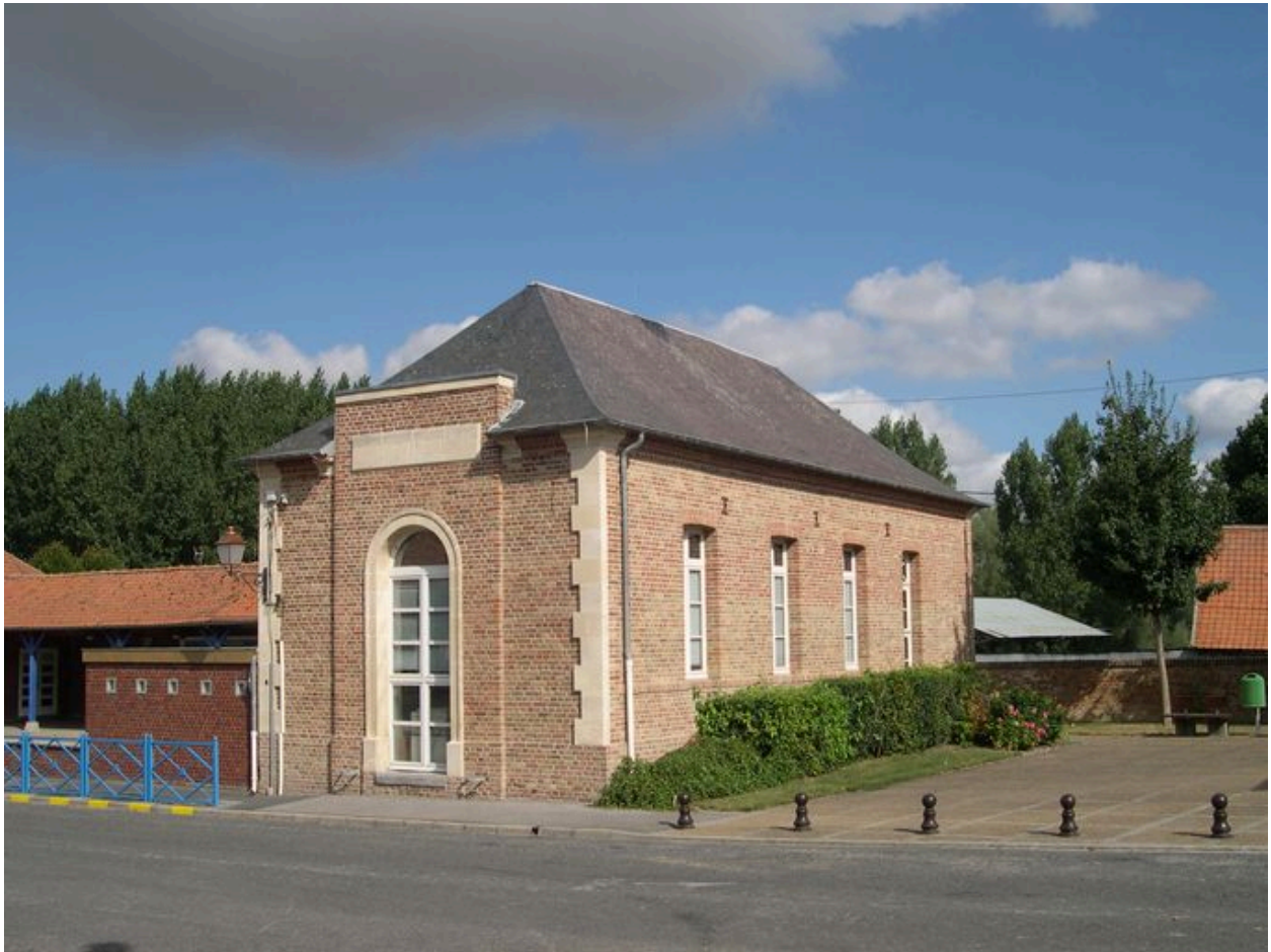
L'école, vue du sud-est.
