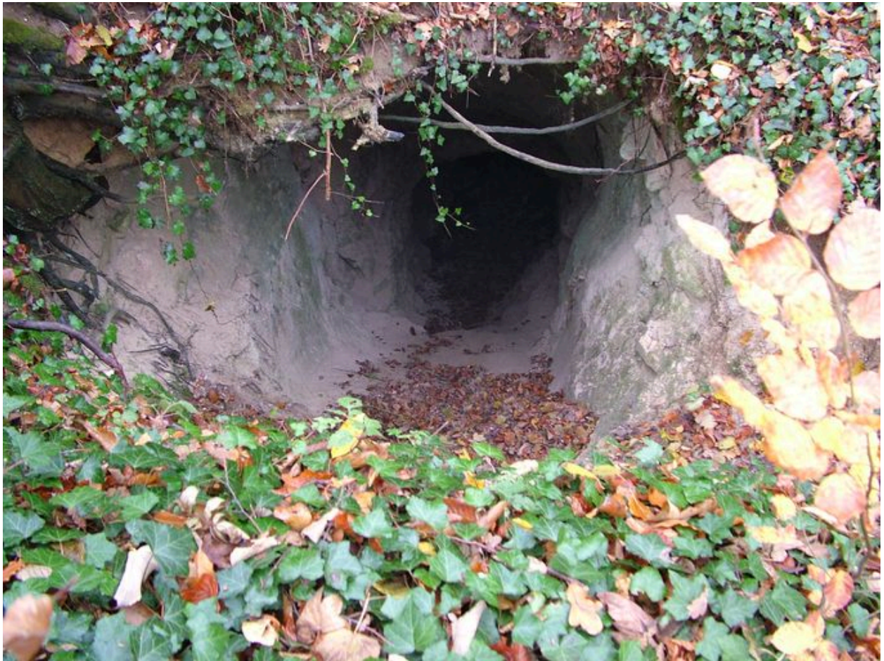
Vue de l'entrée du tunnel.
