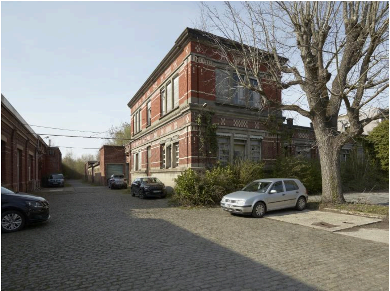
Aile ouest des bureaux, au centre. À gauche, le magasin aux toiles.
