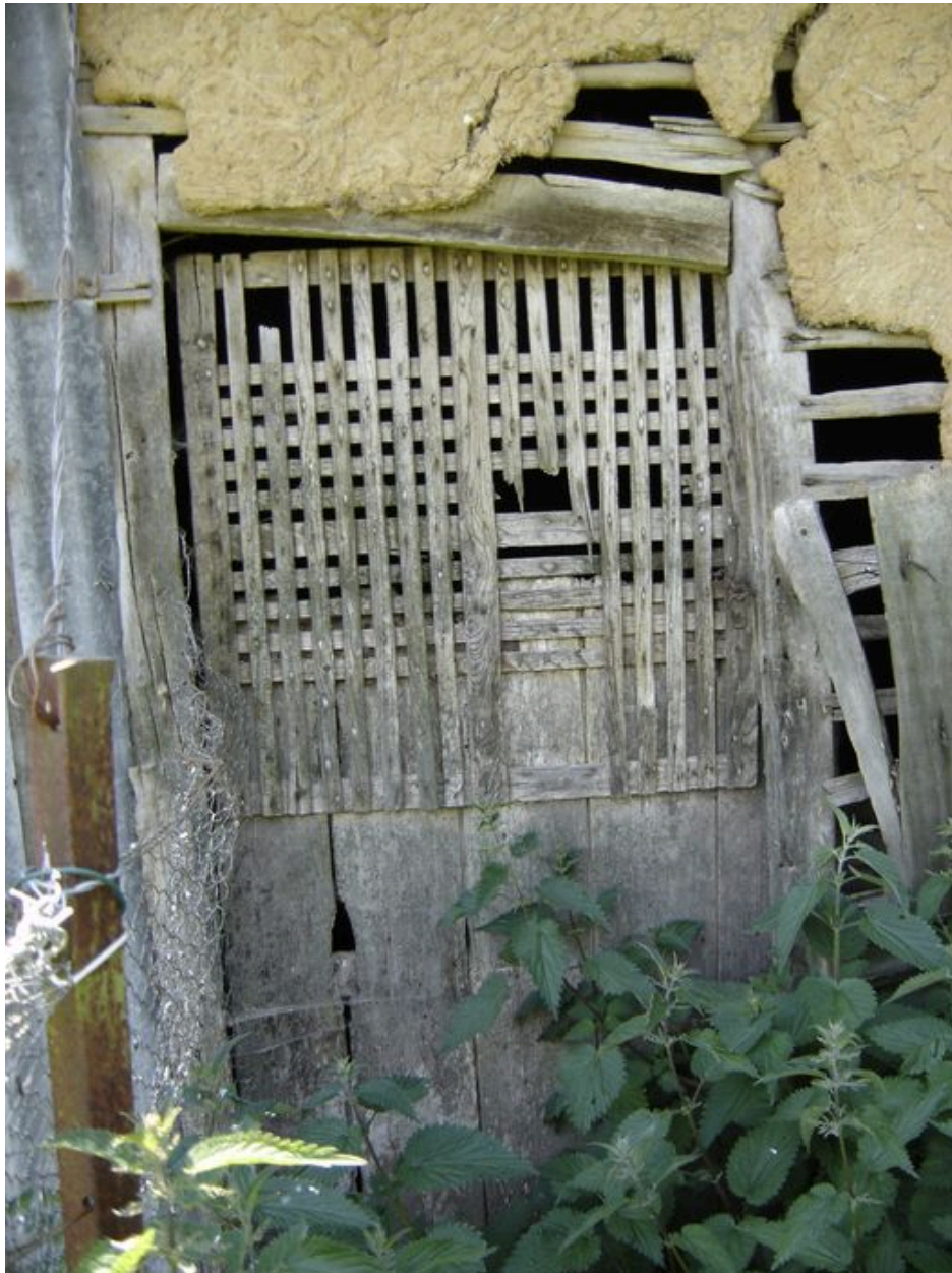
Vue détaillée de la porte de l'abri.
