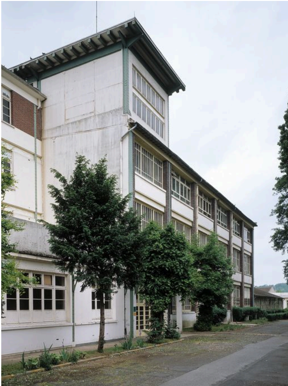
Tour d'escalier du lycée.
