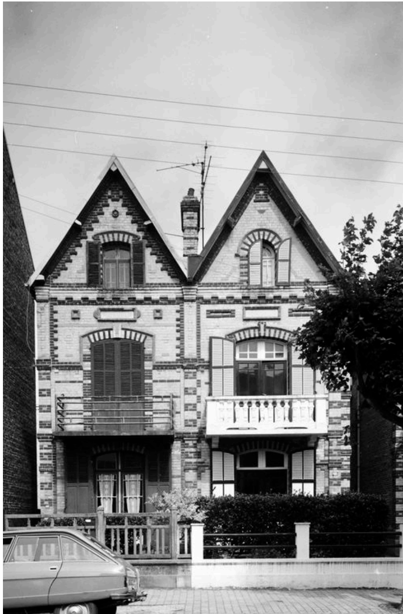
Vue générale du 13, 13bis rue du Docteur-Cazin, en 1981.
