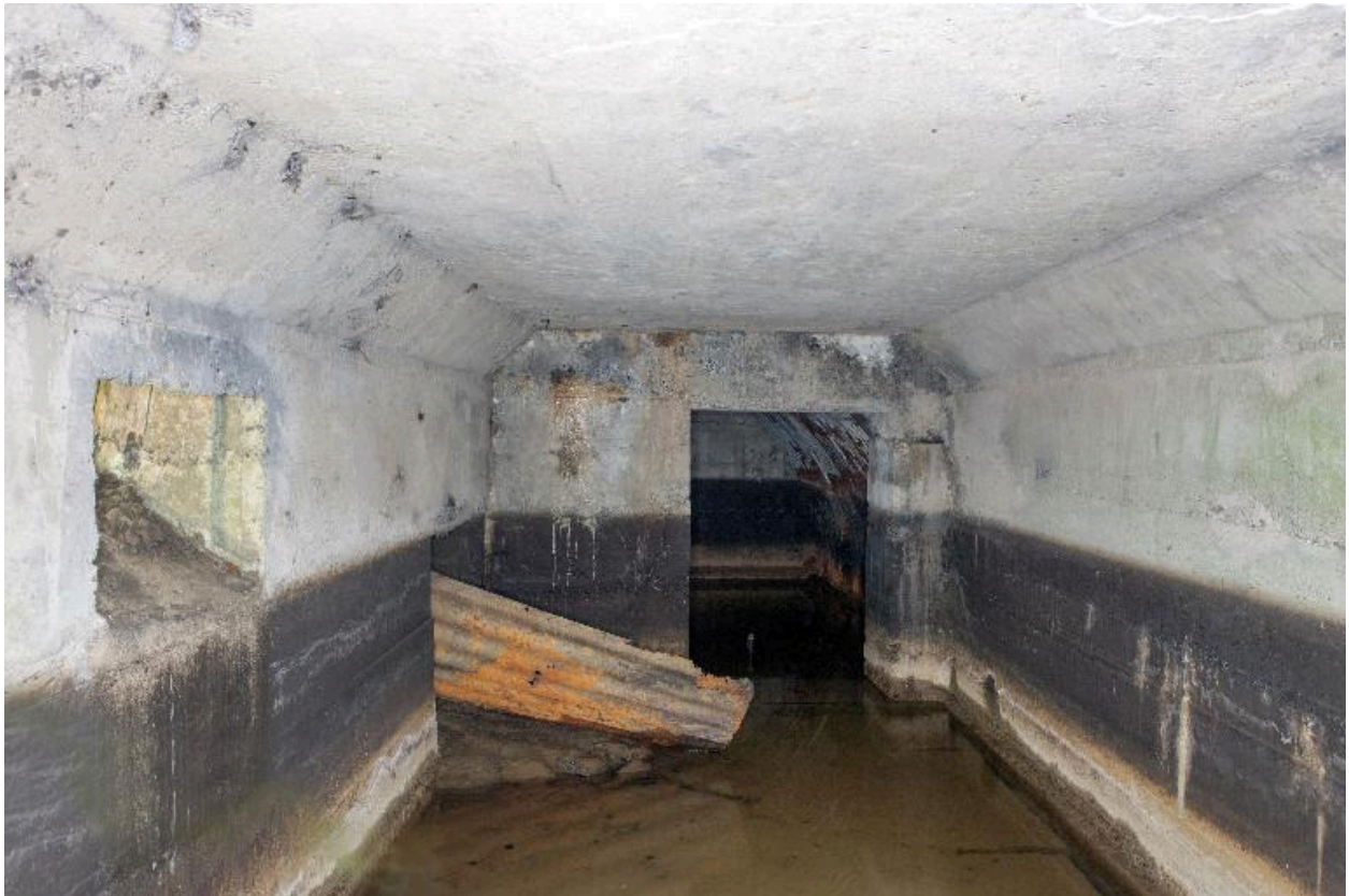
Vue interieure, vers l'ouest
