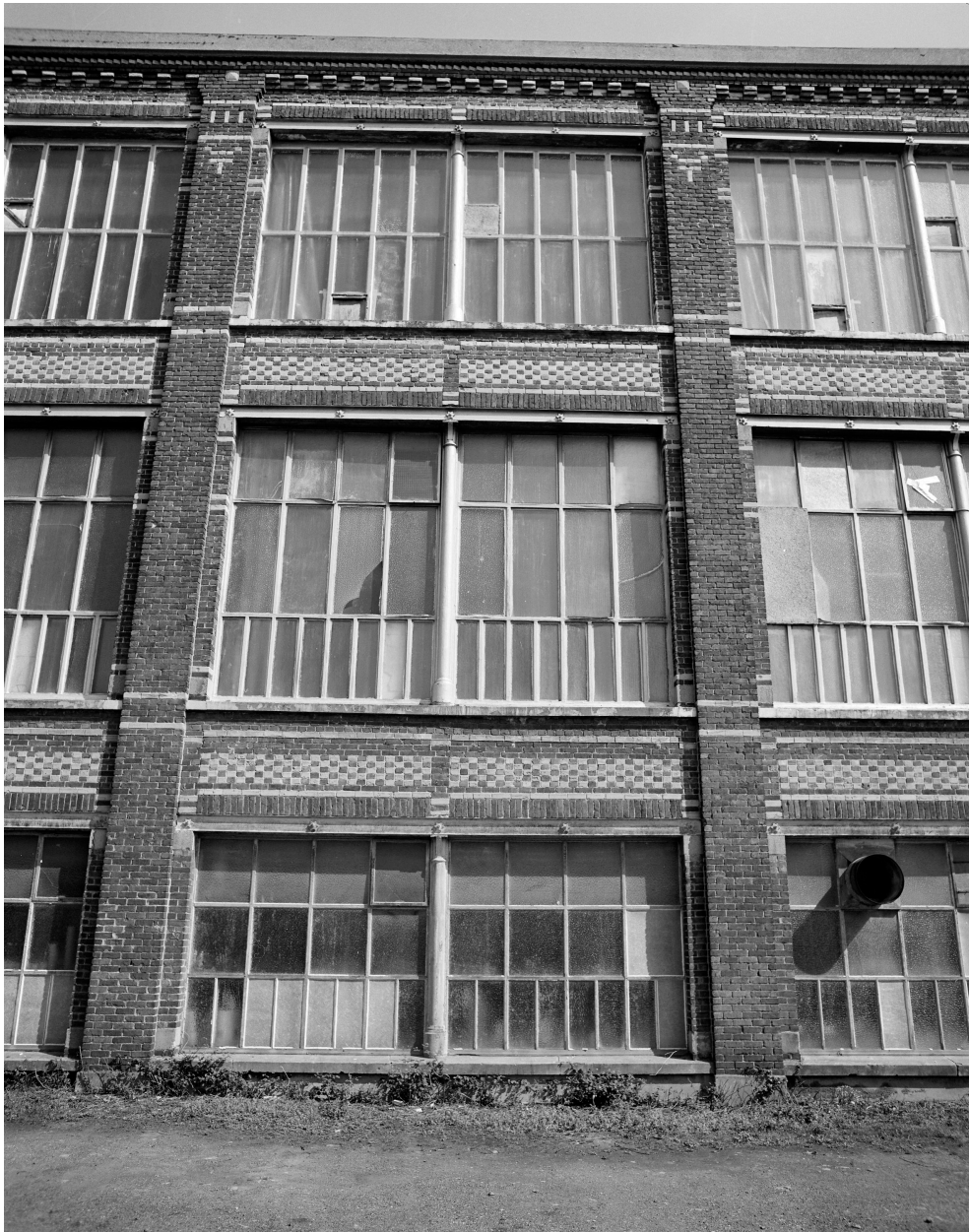
Atelier de fabrication. Une travée.
