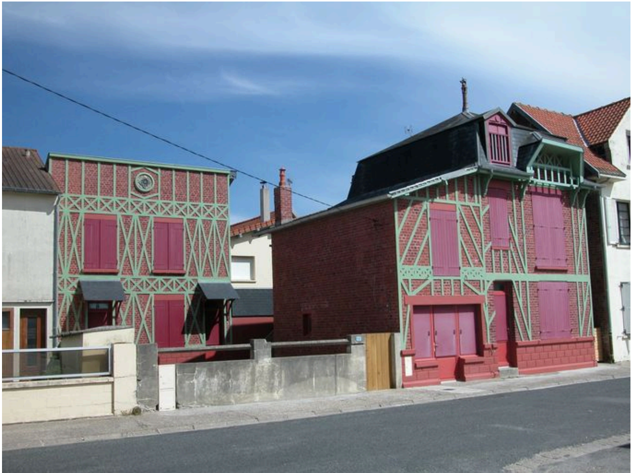
Vue d'ensemble des deux habitations, après restauration.
