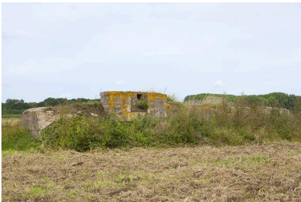
Vue antérieure, vers le nord-ouest
