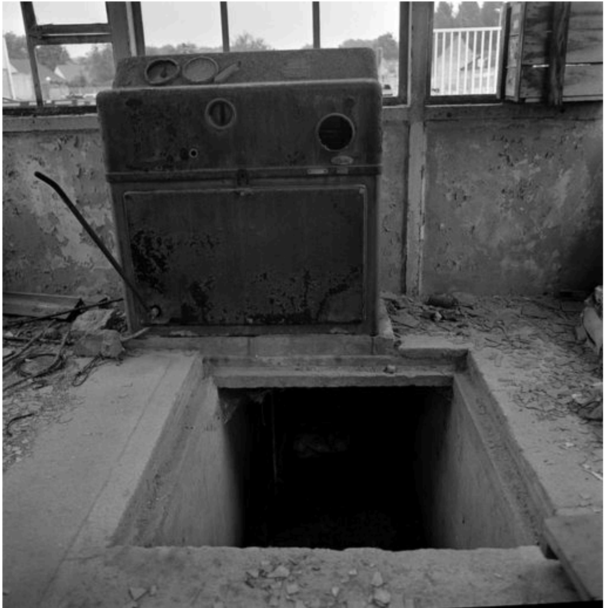
Pont bascule, vue intérieure bureau.
