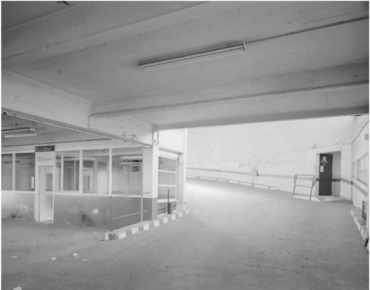
Vue du rez-de-chaussée et du début de la rampe d'accès.
