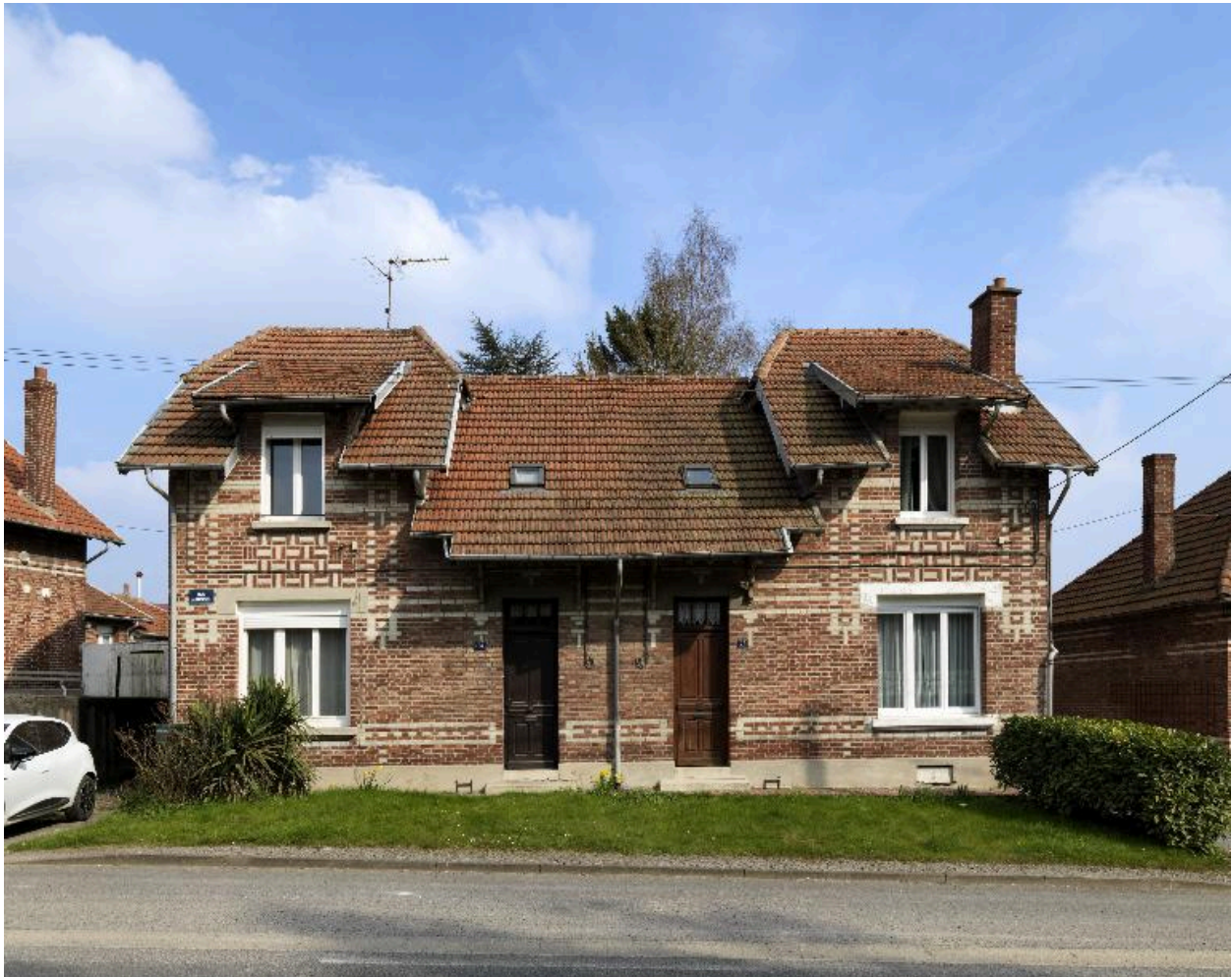
Maison à deux logements (25-26 rue de Roisel).
