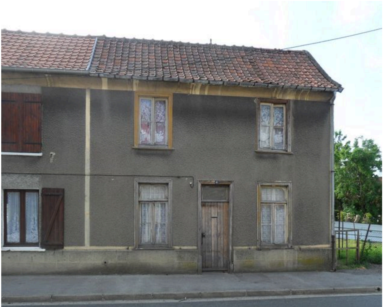
Façade d'un logement.
