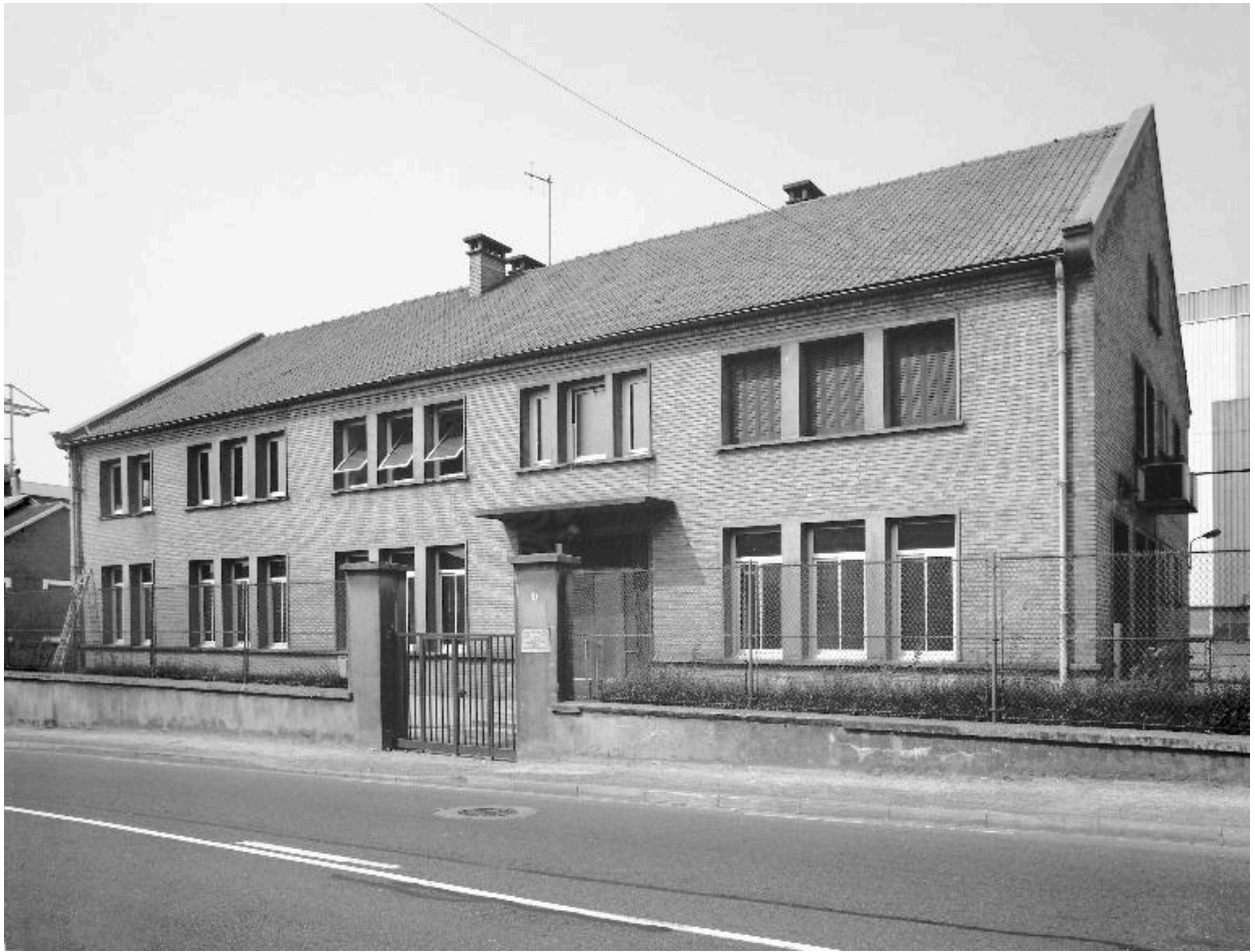
Vue des bureaux, façade est sur la rue.
