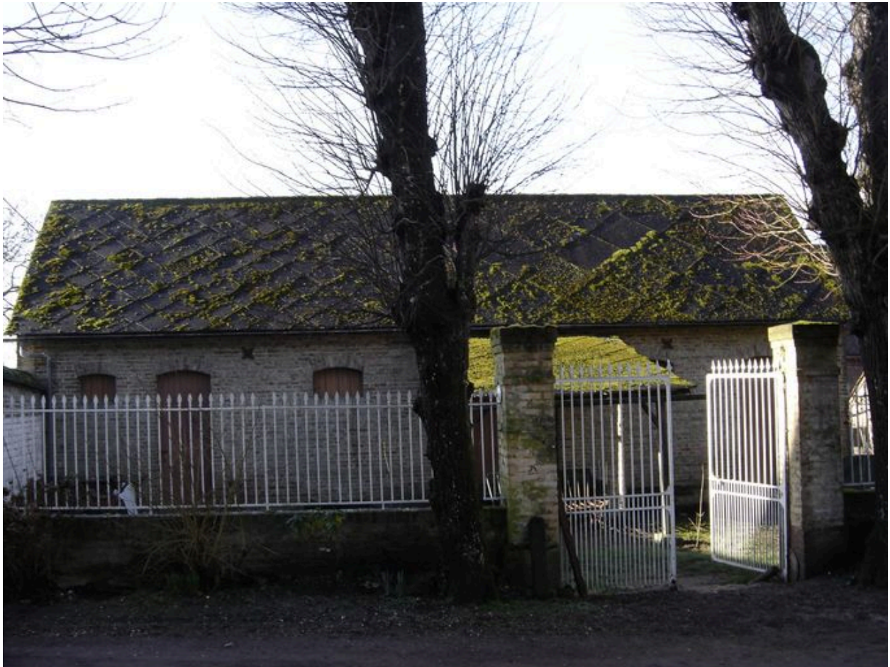
Vue de la grange à l'entrée de la cour.
