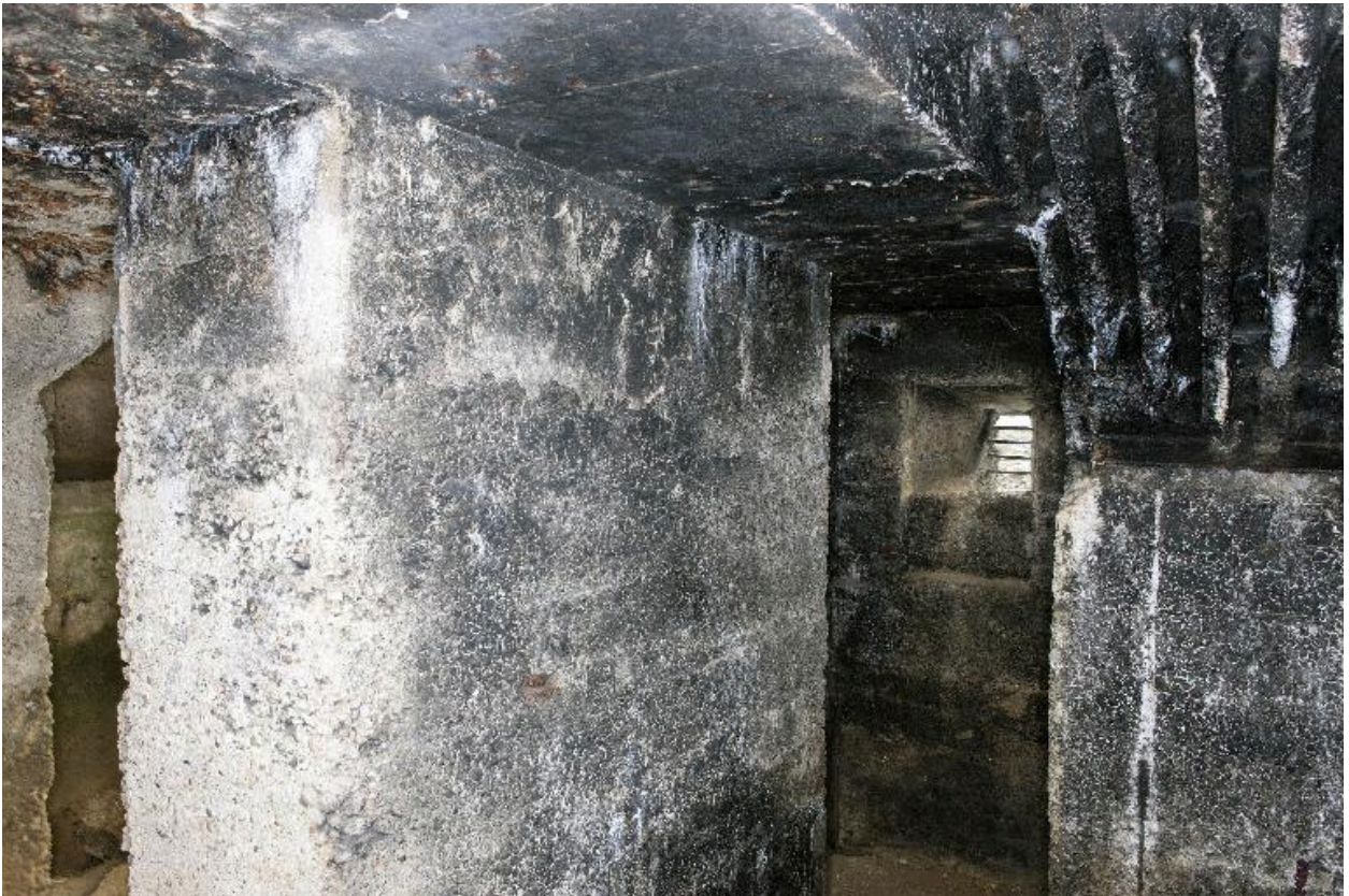
Créneau de fusillade nord, depuis le couloir
