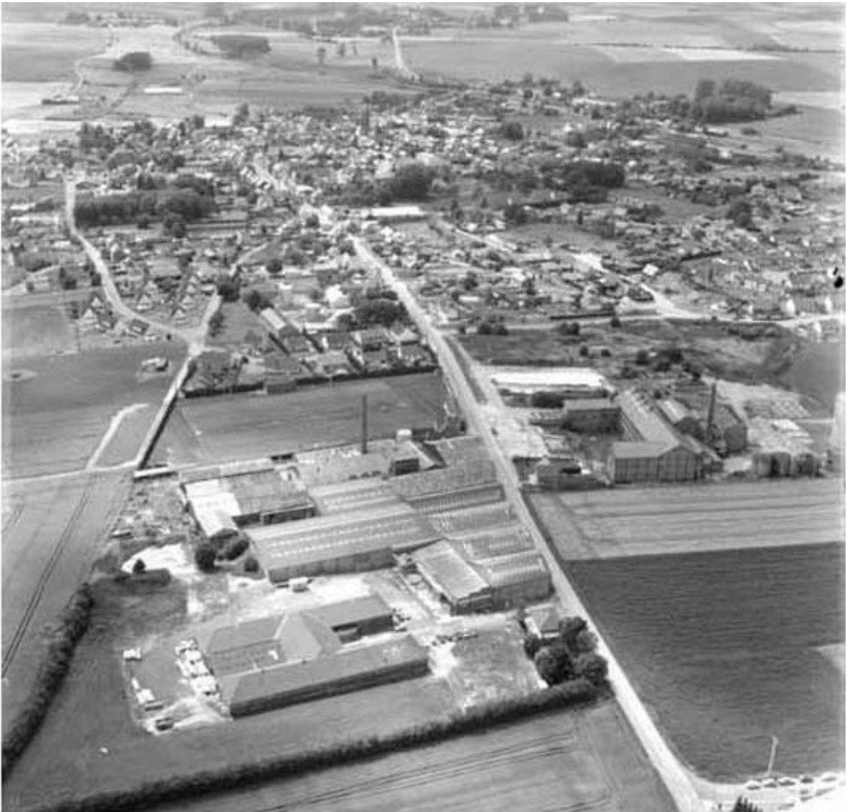
Vue aérienne, flanc est.
