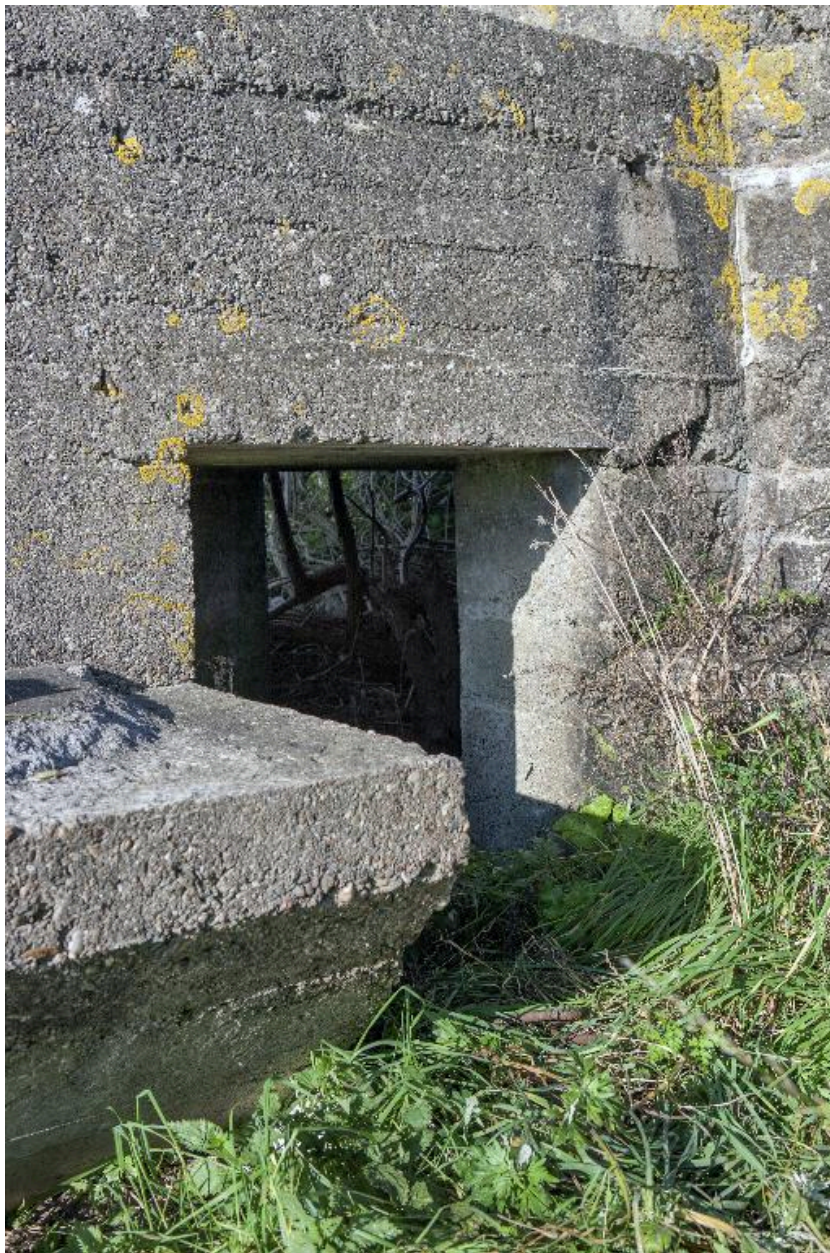
Entrée ouest. Entrée pare-souffle.
