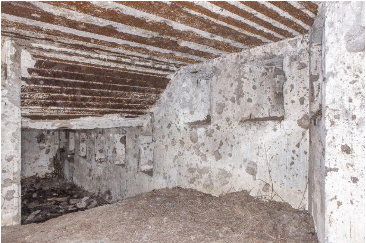
Créneaux de fusillade depuis le premier niveau de l'édifice vers le niveau intermédiaire
