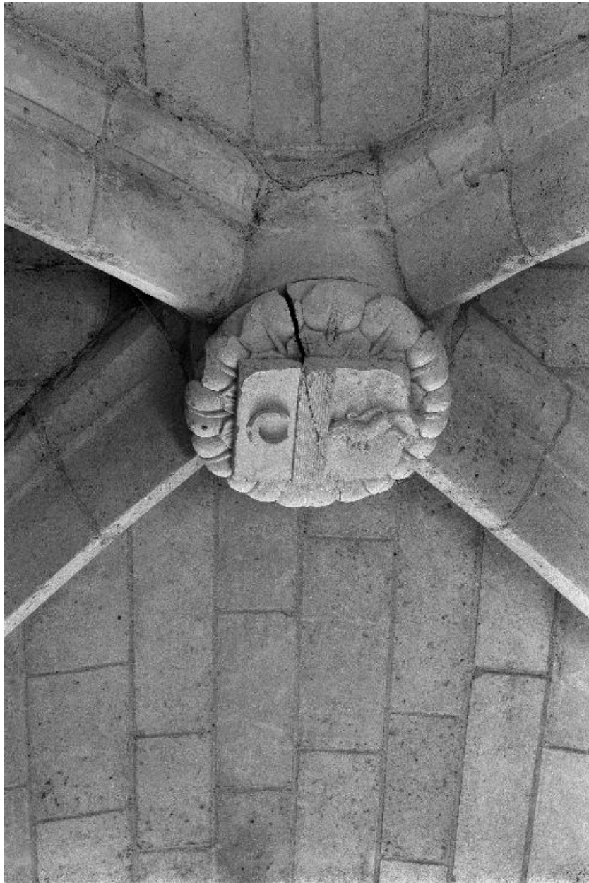
Clef de voûte de la chapelle ouvrant au nord de la nef, ornée des armoiries de la famille Marquet de Montbreton.
