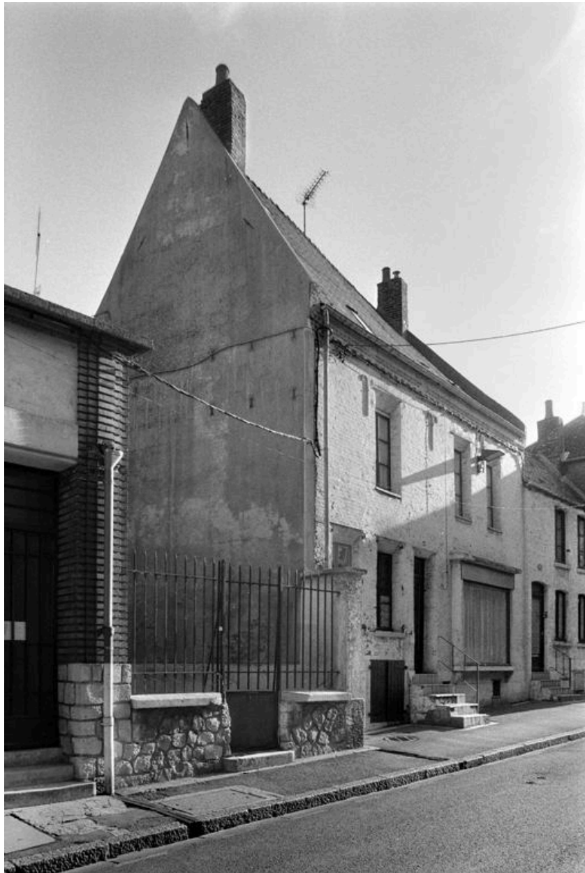
Vue de l'élévation sur rue.
