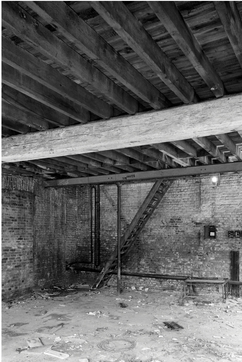
Remise, vue intérieure du rez-de-chaussée.
