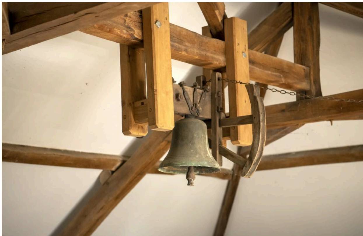
Cloche de la mairie-école, sous comble.
