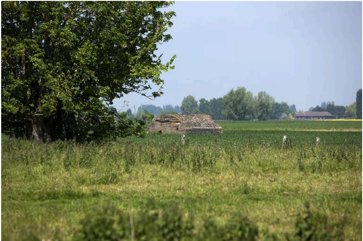
Vue générale, vers le nord ouest
