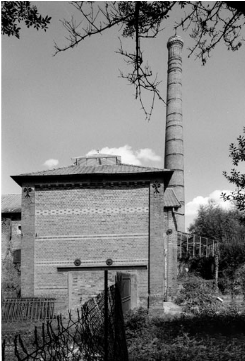
Le bâtiment d'eau et la cheminée, à l'arrière-plan.
