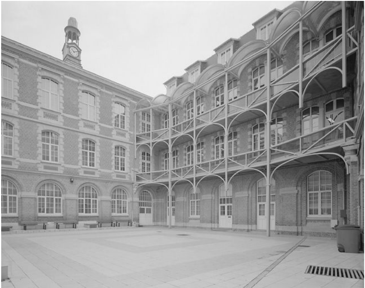
Cour intérieure et coursière de distribution.
