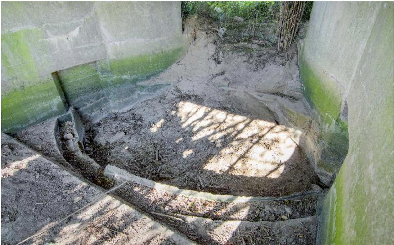
Vue intérieure vers le sortie de la chambre de tir avant déblaiement. Au sol apparait les infrastructures de la plate-forme d'artillerie, notamment le chemin de roulement du support de crosse
